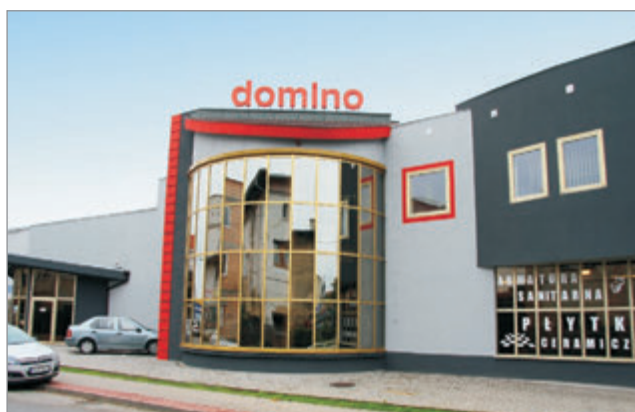
Biuro przy ul. Rzeźniczej
