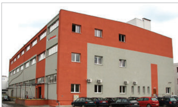
Główny magazyn przy ul. Batalionów Chłopskich
